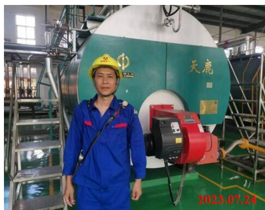
现场测量相片
