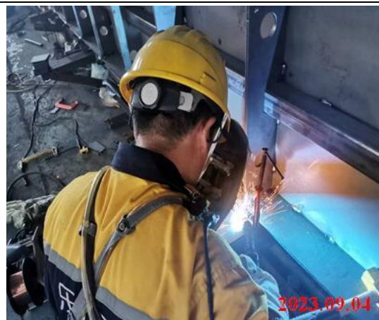
现场测量相片
