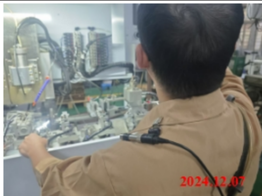
现场测量相片
