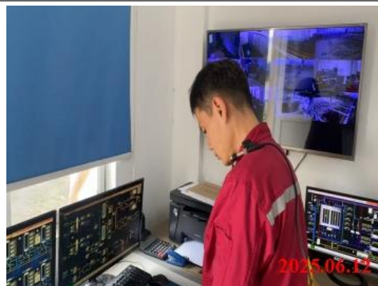
现场测量相片
